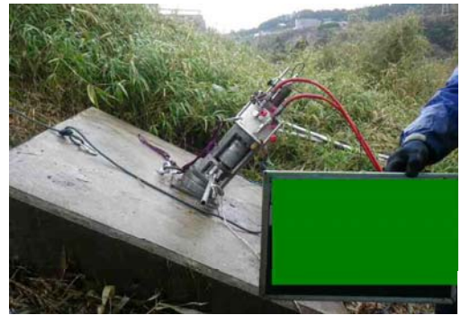
写真 2. 荷重試験状況
