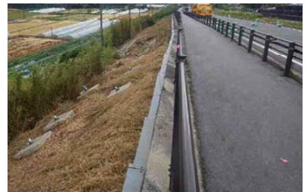
写真 1. アンカーのり面状況
