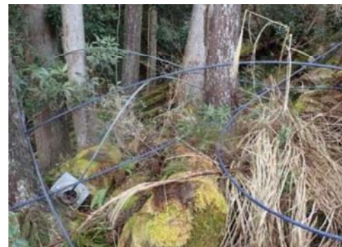
写真 1 アンカー飛出しの様子
