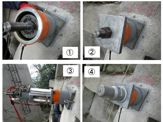
図 7. 余長無しアンカーの後付け荷重計の設置状況
