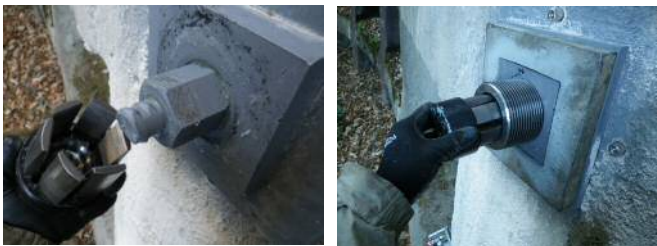
図 5. 余長無し専用治具の設置状況
