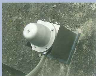
⑧ 設置完了
