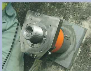
③ 荷重計設置
