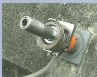
⑤ アタッチメント設置
