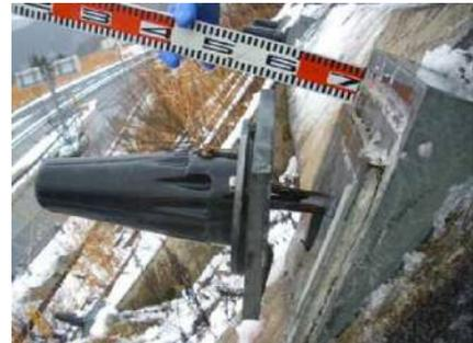
写真2 供用後引き抜けが確認されたアンカー
